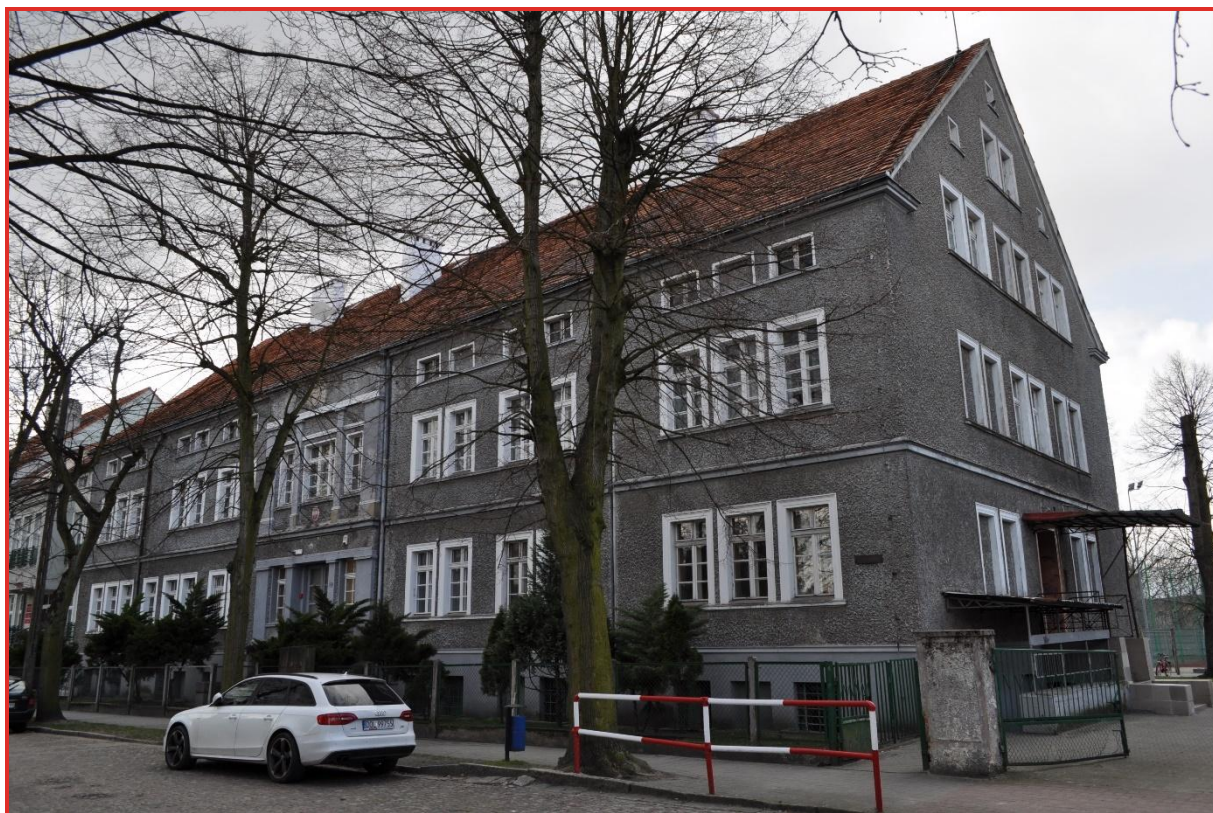
Rysunek 22. Budynek pomieszczeń administracyjnych Przedszkola, Biblioteki i Centrum Usług Wspólnych w Bierutowie, ul. Kolejowa.
