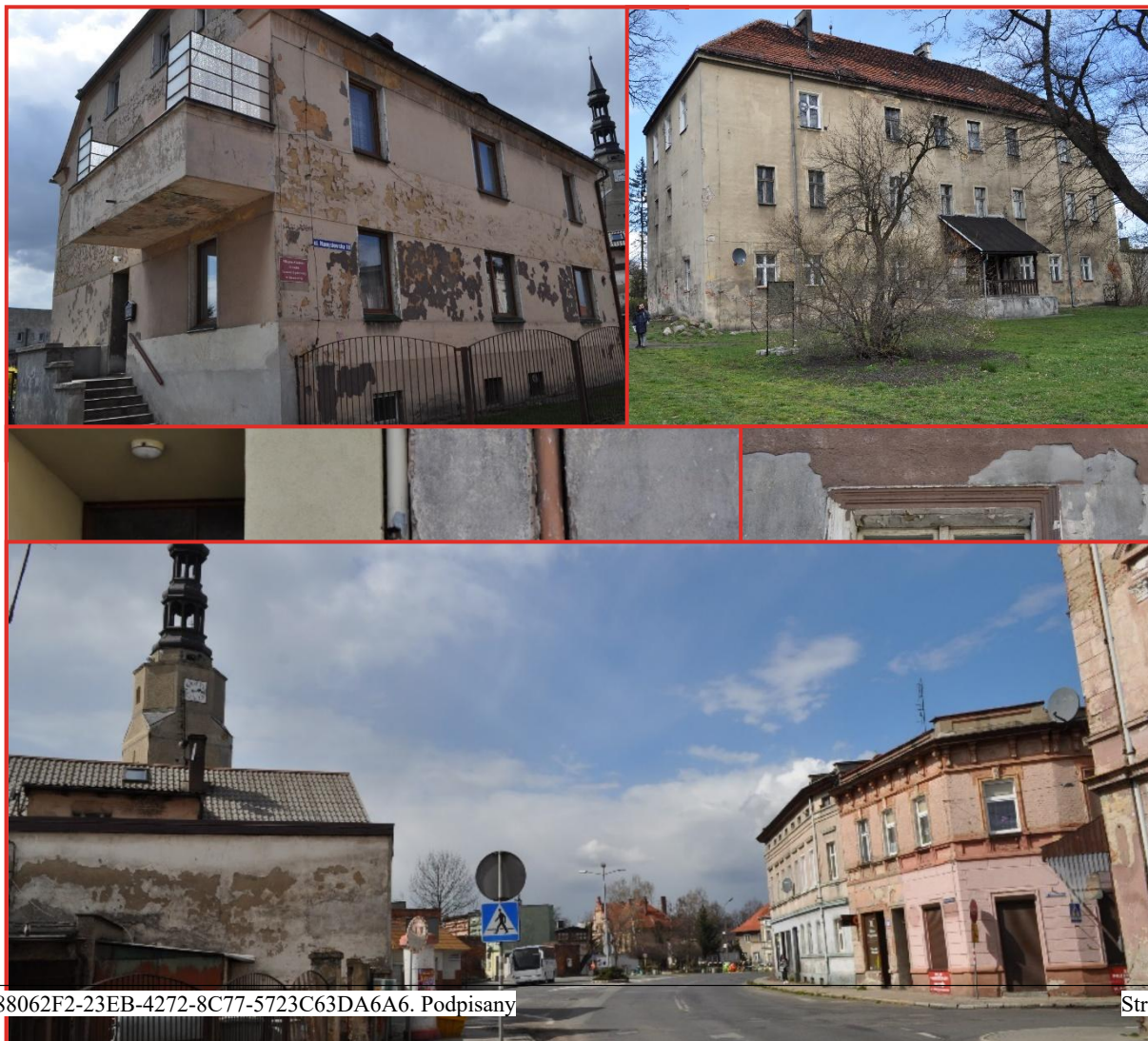
Rysunek 20. Stan techniczny budynków na obszarze rewitalizacji: (1) budynek Miejsko-Gminnego Ośrodka Pomocy
