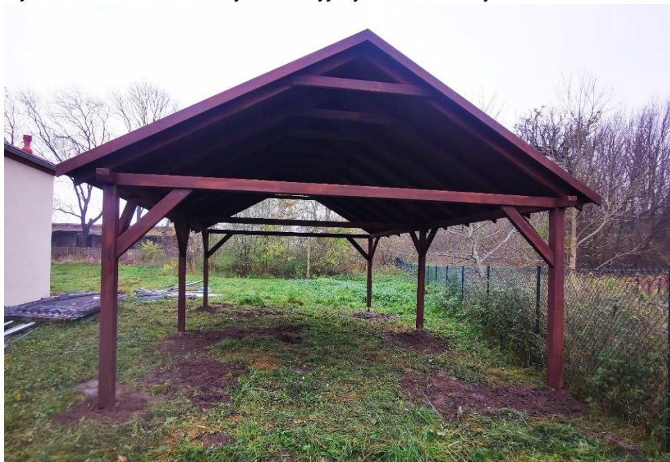
Rysunek 19 Budowa wiaty rekreacyjnej w Strzałkowej
