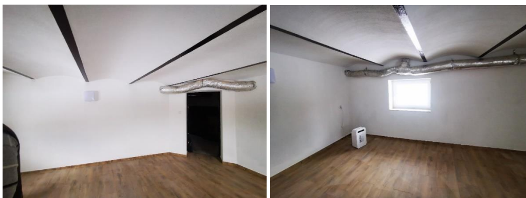
Rysunek 10 Modernizacja budynku świetlicy wiejskiej w Posadowicach – etap II
