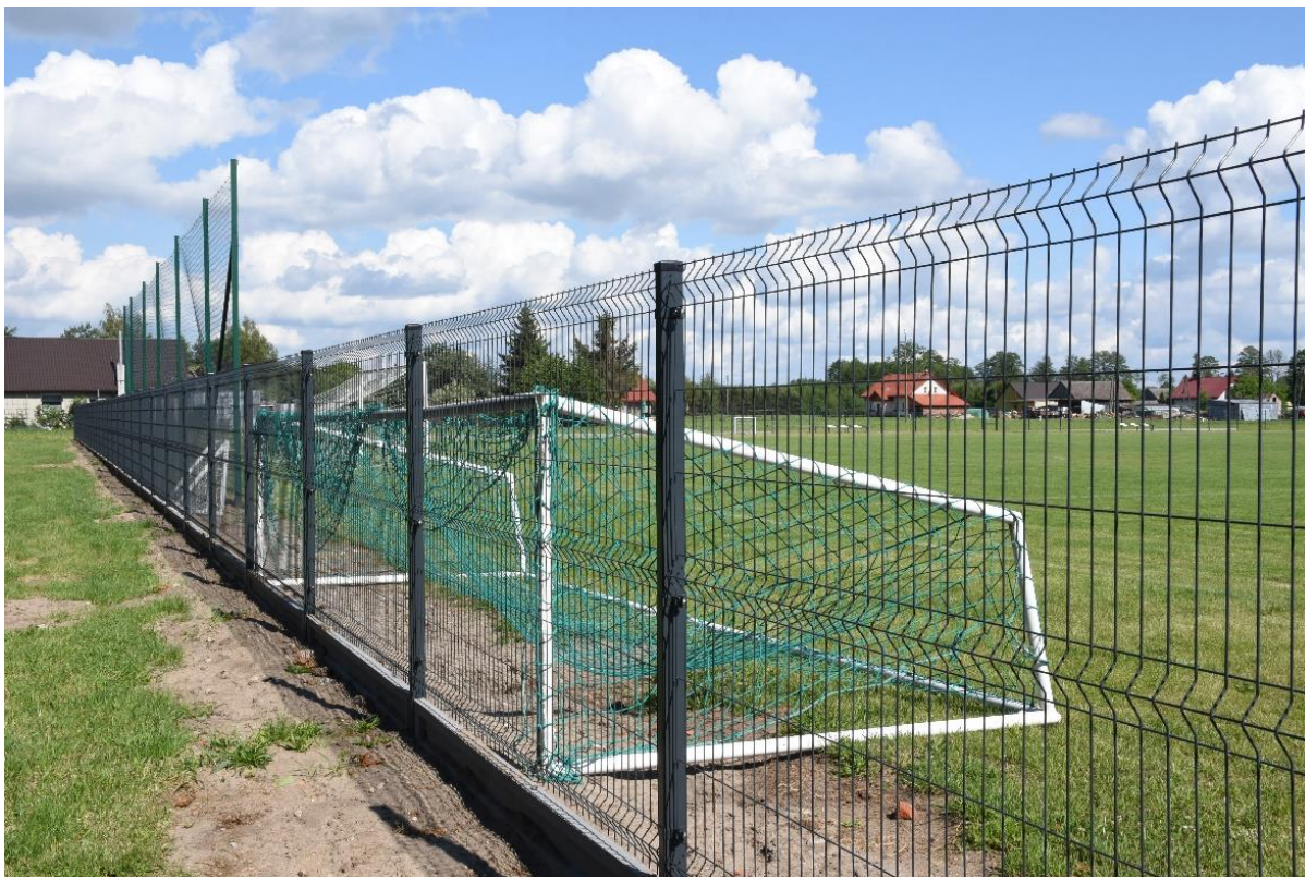
Rysunek 17 Budowa ogrodzenia terenu sportowo-rekreacyjnego w Zbytowej
