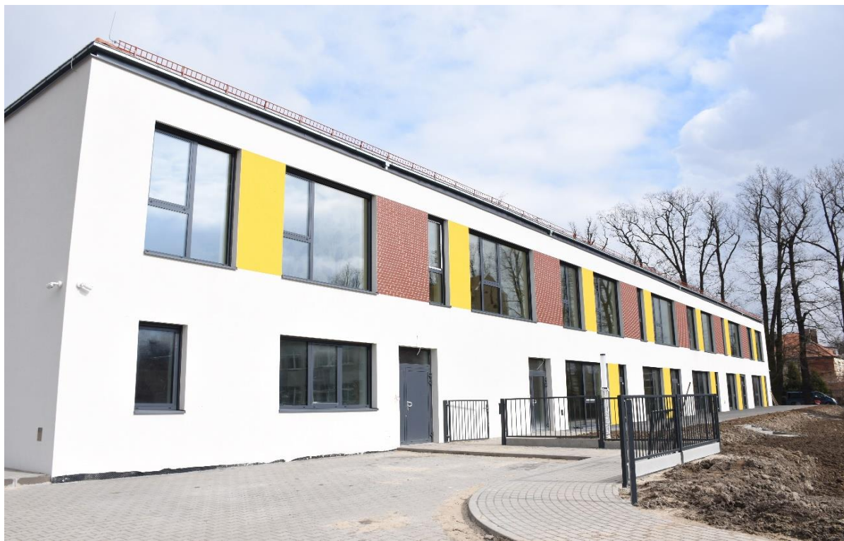
Rysunek 12 Budowa Przedszkola Miejskiego w Bierutowie – etap II
