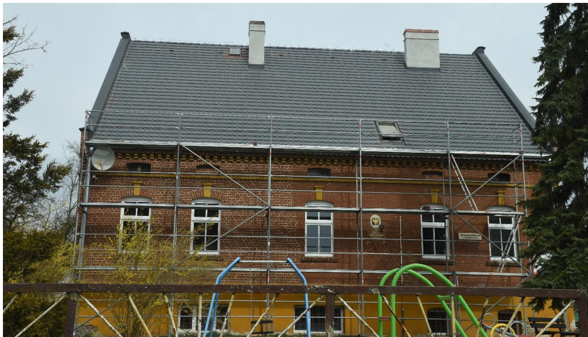
Rysunek 9 Modernizacja budynku świetlicy wiejskiej w Posadowicach – ETAP I
