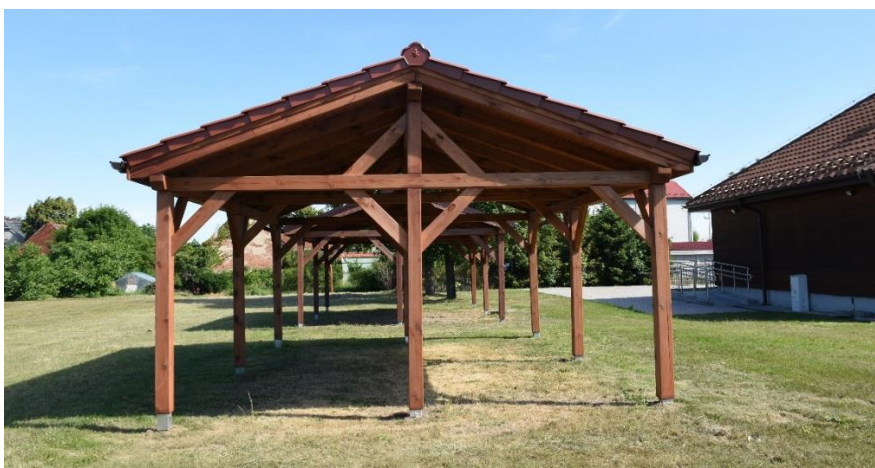
Rysunek 18 Budowa wiaty rekreacyjnej w Zawidowicach
