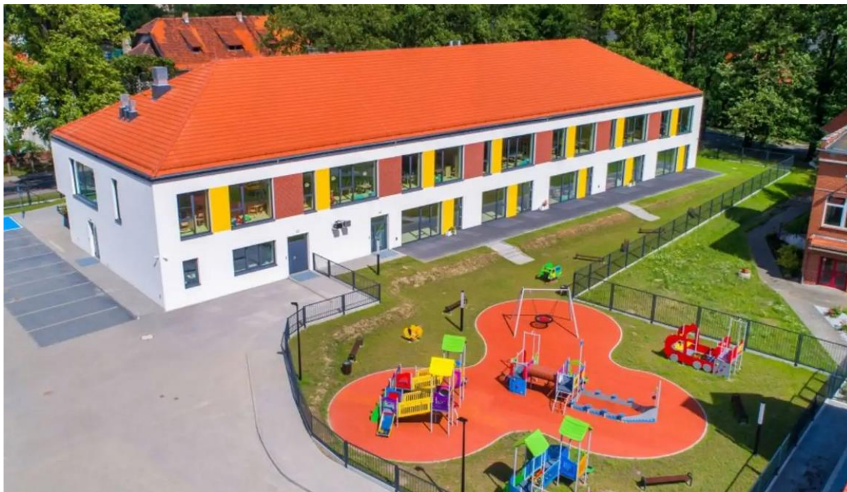
Rysunek 9 Budowa Przedszkola Miejskiego w Bierutowie – etap II
