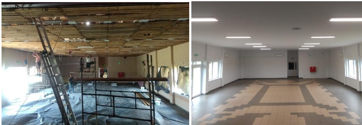
Rysunek 3 Modernizacja Sali głównej w świetlicy wiejskiej w Zbytowej
