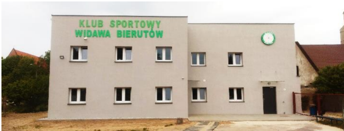
Rysunek 2 Modernizacja Domu Sportowca przy ul. Namysłowskiej w Bierutowie
