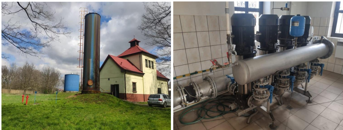
Rysunek 17 Modernizacja stacji uzdatniania wody w Bierutowie
